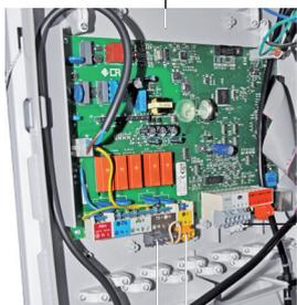
Raccordement 1<sup>er</sup> circuit avec vanne mélangeuse
